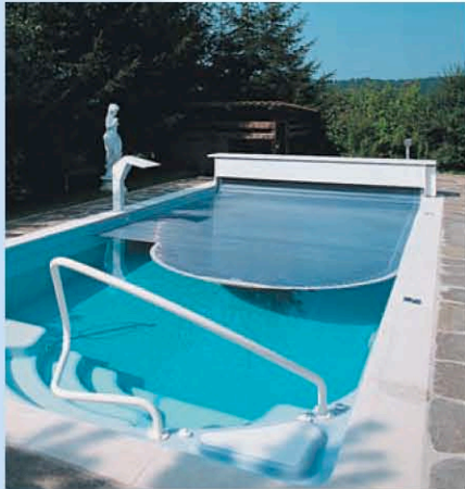
Cubierta a ras de suelo
